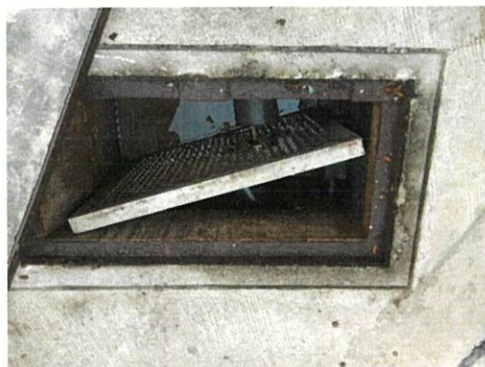
รูปที่ 25 ตะแกรงดักมูลฝอยที่บ่อพักน้ำสุดท้าย
