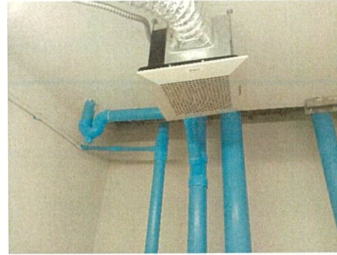
รูปที่ 24 พัฒนาระบายอากาศในห้องพักรวมฝอย
